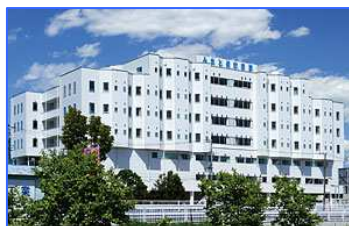
みさと健和病院 埼玉県三郷市
